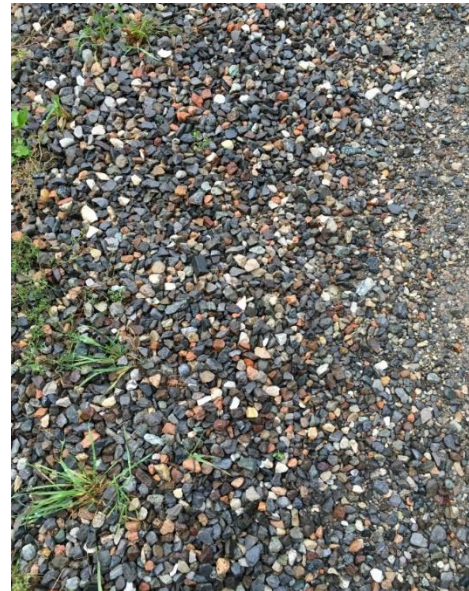
Fig. 2. Camino de grava de Villa Casana, Novedrate, Italia
