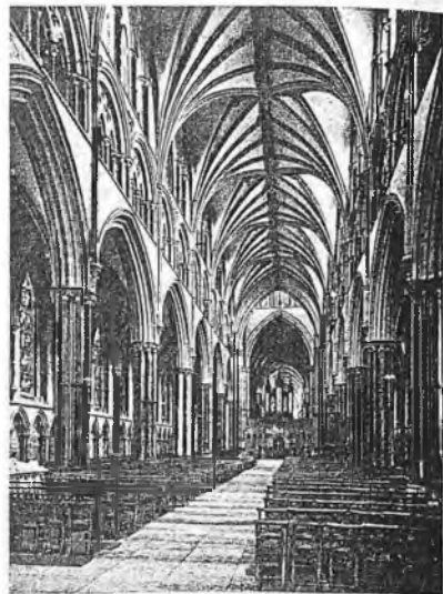
[376] Catedral de Lincoln, vista de la nave mayor hacia el este, abovedamiento concluido en 1233. Aumento de los elementos lineal-decorativos. Nervaduras diagonales suplementarias y nervaduras longitudinales corridas enriquecen la forma de abovedamiento.
