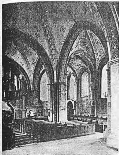
[262] St. Maria de Höhe, en Soest, principios del s. XIII. Vista hacia el este. Los distintos tramos, con sus bóvedas ascendentes cupularmente, han sido conjuntados en un compacto recinto de salón. Algunas de sus formas muestran ya indicios del Gótico: arco apuntado y pilares articulados con mayor riqueza.
