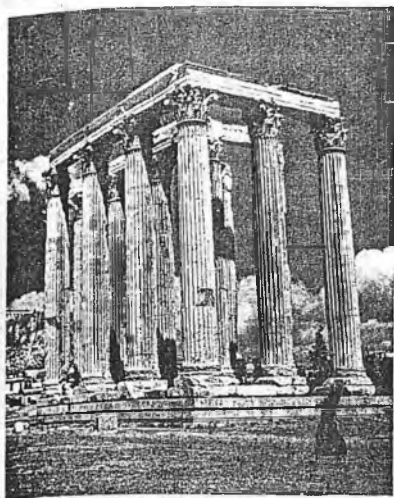
[91] Columnas del templo de Zeus Olímpico en Atenas, parte del edificio de Cosutius bajo Antíoco IV (175-164 a. C.). Adopción del capitel corintio en lugar del jónico en el exterior del templo.
