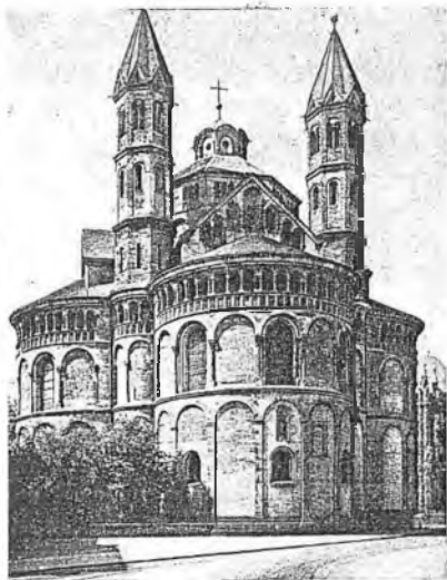
[263] Coro de los Santos Apóstoles en Colonia, comenzado en 1192. Readopción de la planta trebolada [258]. Fusión de las diversas partes en un compacto bloque arquitectónico. Aligeramiento de los volúmenes murales por articulaciones de arco de medio punto con fuerte acentuación de las horizontales. Efecto pictórico por ahuecamiento sobreante de la pared, de abajo hacia arriba (galería enana).
