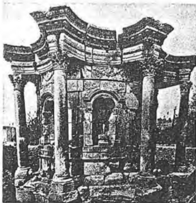
[122] Templo circular (¿de Tyche?) en Baalbeck (Heliópolis, Líbano) de finales del s. II y comienzos del III d. C. Templo romano de podio. Movimiento barroco producido por la curvatura del estilobato y el arquiteabo, de modo que el peristilo resulta quebrado. Ornamento vegetal de la época tardía.
