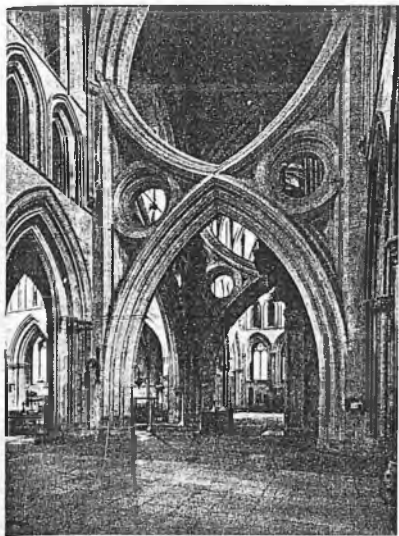
[377] Crucero de la catedral de Wells con arcos de contrarresto añadidos posteriormente, en 1338, que caracterizan, igual que los nervios de abanico en el bovedaje, el fantástico mundo del decorated style .
