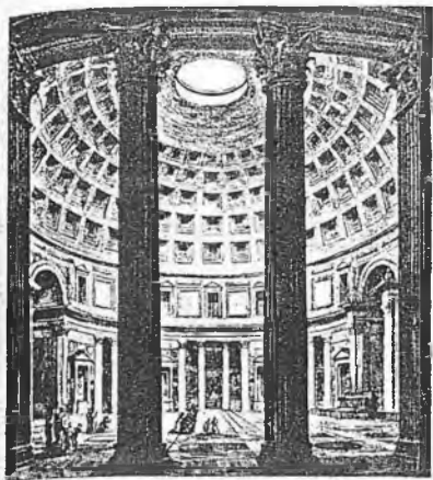
[119] Interior del Panteón de Roma, erigido entre el 120 y el 126 d. C.; grabado de Antonio Sarti del año 1829. Es el más puro interior romano y obedece a una concepción abstracta y matemática; la pared, sin valor por sí misma, hace el papel de caparazón del recinto, en cuya estructura se utiliza el orden arquitectónico jónico.
