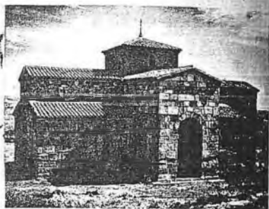
[212 - 213] Iglesia visigoda de San Pedro de la Nave, en Zamora, s. VIII. En la vista exterior son claramente perceptibles la sección basilical y la forma de cruz latina. Sobre la intersección de los brazos de la cruz se alza la torre de crucero. El interior produce el efecto espacial de una fosa en la nave central, con bóveda de cañón. Arcadas con arcos de herradura. En los capiteles, primeras muestras de ornamentación figurativa.
