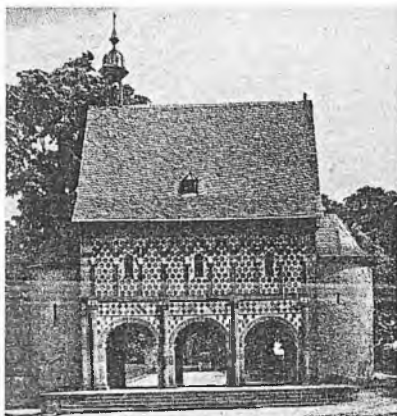
[211] Pórtico del monasterio de Lorsch, hacia el 770. Antepuesto probablemente como sala real y de recepción ante la primitiva iglesia monasterial. Acceso al primer piso por torres semicirculares de escaleras. En la ornamentación de la fachada, transformación de motivos antiguos mediante una concepción plano-decorativa.
