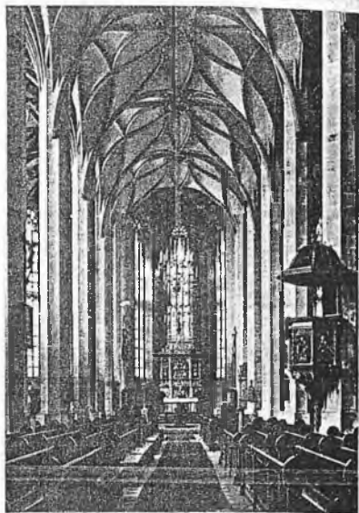
[414] Iglesia de Santa Ana en Annaberg, 1499-1522. Nave mayor hacia el este. Hallenkirche sajona de la fase más tardía del Gótico. Recinto muy unitario con bóveda de bragueteras curvados y concebidos como pura decoración (ya no arquitectónicamente).
