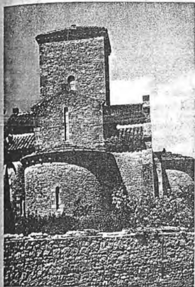
[206-207] Iglesia de Germigny-des-Prés en Orleáns, consagrada el 806. Planta y vista exterior. Composición escalonada de ábsides, recintos laterales y brazos de crucero, que culminan en la alta cúpula central en forma de torre. Planta con cruz griega inscrita y recintos laterales cuadrados según modelo bizantino; los ábsides, en parte, con la forma de herradura visigótica.
