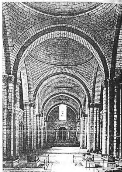
[276] Nave mayor de la iglesia de Fontevault, posterior a 1120. Iglesia cupular aquitánica. De la yuxtaposición de recintos cupulares individuales surge un cuerpo longitudinal de una sola nave, que desemboca en un coro con girola. Principio acumulativo típicamente románico. Configuración plástica de pilares y paredes a base de semicolumnas.
