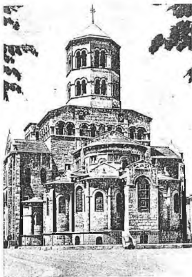
[272] Iglesia de St. Austremoine, en Issoire, principios del s. XII, torre de crucero renovada. La parte oriental de las iglesias de Auvernia está configurada por un piso a manera de zócalo, que brota del transepto y está adornado con arcadas, y sobre el que se alza la torre del crucero. También en el exterior se utiliza la incrustación de piedra de color.
