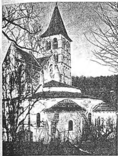
[221] Iglesia prioral en Vigny, comenzada a finales del s. X; consagrada en 1050. La vista por el sudeste muestra el escalonamiento, típico del coro con girola, de las partes arquitectónicas (frontón de la nave mayor, cabecera del coro, deambulatorio y capillas) en un conjunto diferenciado, orgánicamente unido.
